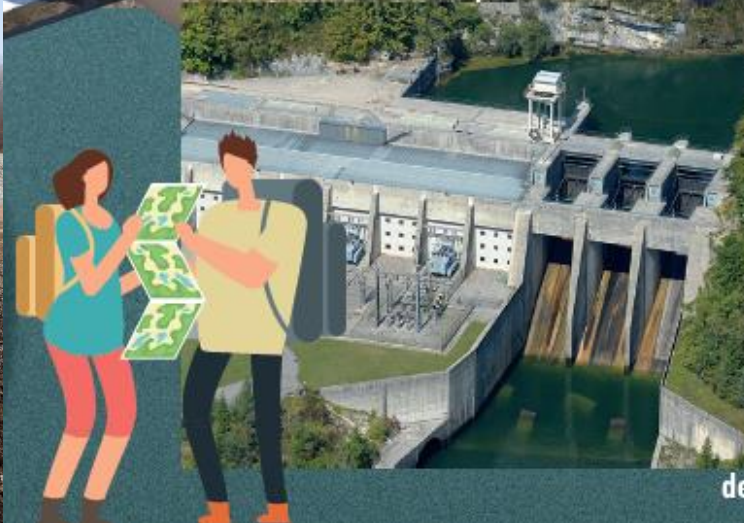
TRAVAUX DE LA PLAGE DE SURCHAUFFANT
